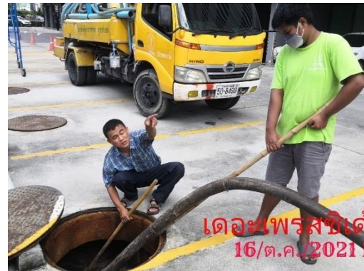
สูบล้างส่วนเกินจากระบบบำบัดน้ำเสีย
