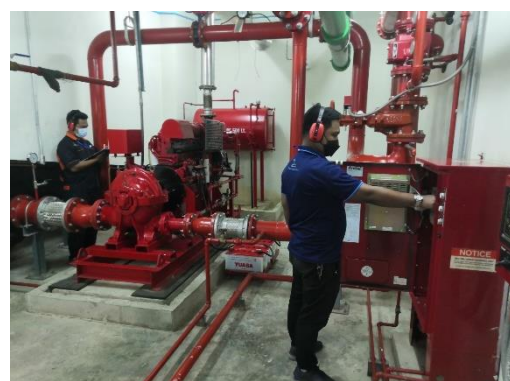
ตรวจสอบปั้มน้ำดับเพลิง
